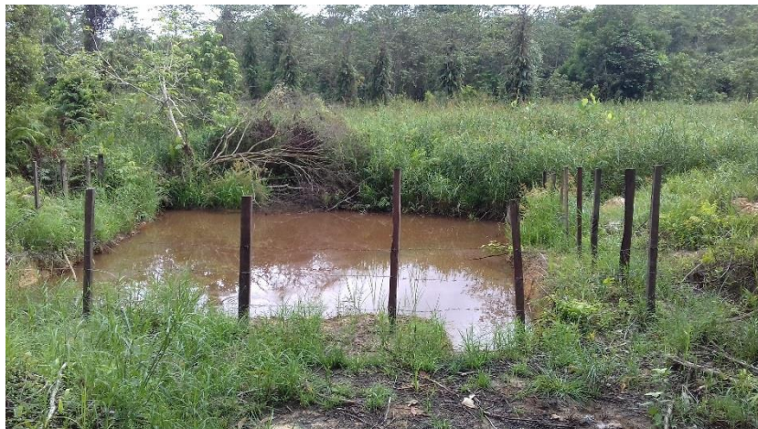
完成した貯水池
