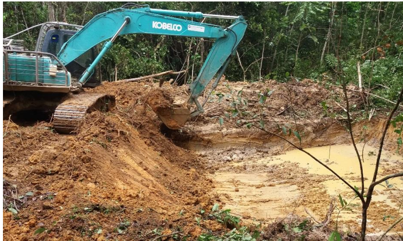
貯水池建設の様子
