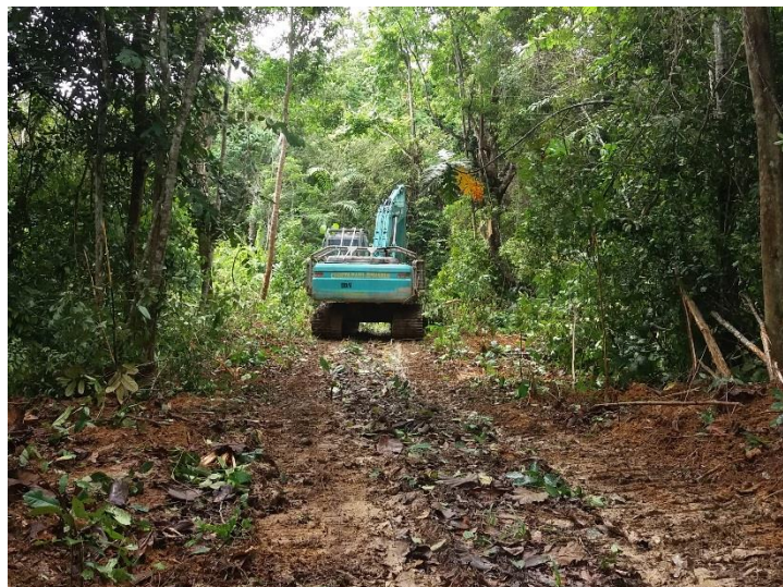
防火帯整備の様子
