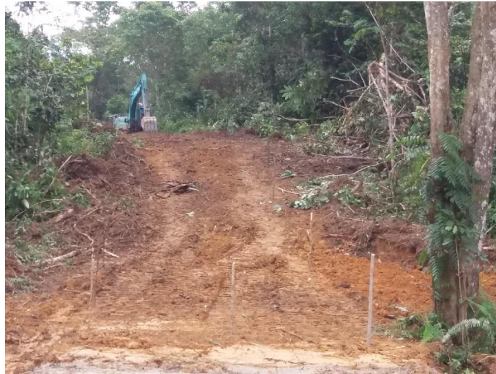
防火帯敷設の様子
