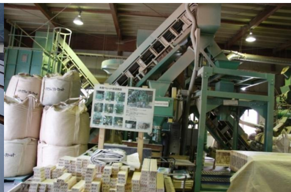
<木質ペレット製造設備>
