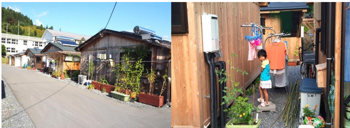
<木造仮設住宅の様子>
