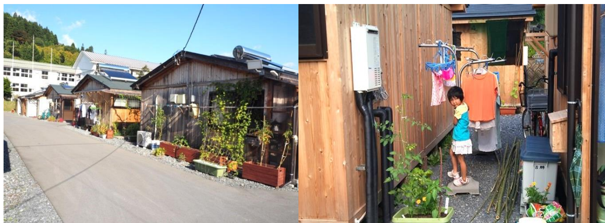
<木造仮設住宅の様子>
