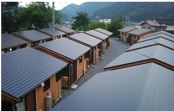
<上から見た木造仮設住宅>
