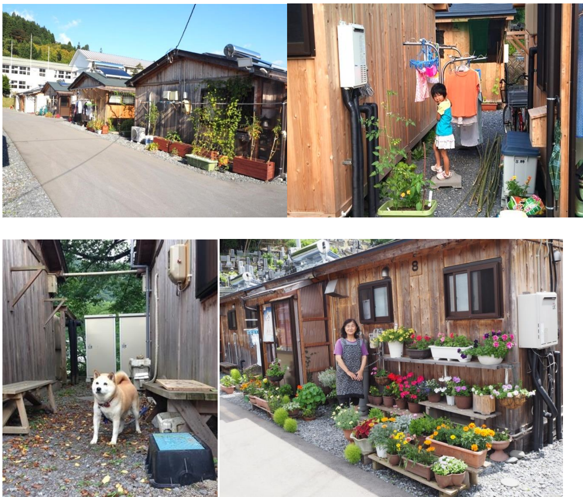
＜木造仮設住宅の様子＞
